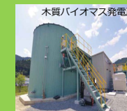
木質バイオマス発電所
